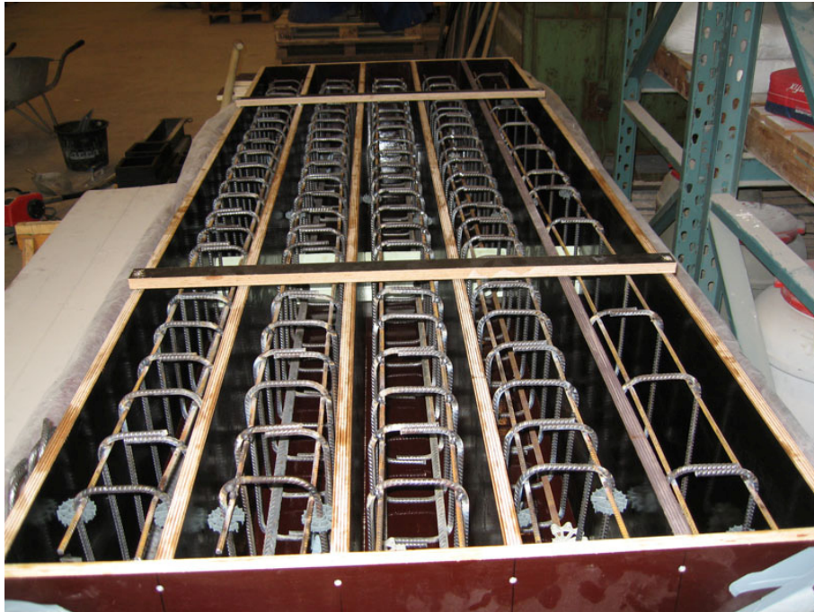
Afbeelding 2.4: Wapeningskorven in de bekisting voor het storten
